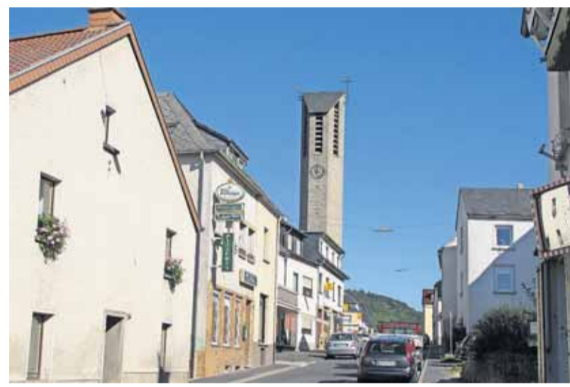
An vielen Stellen eng, mit Schlaglöchern übersät und hier und da Leerstand – die Hauptstraße in Irrel hätte eine Auffrischung nötig.
